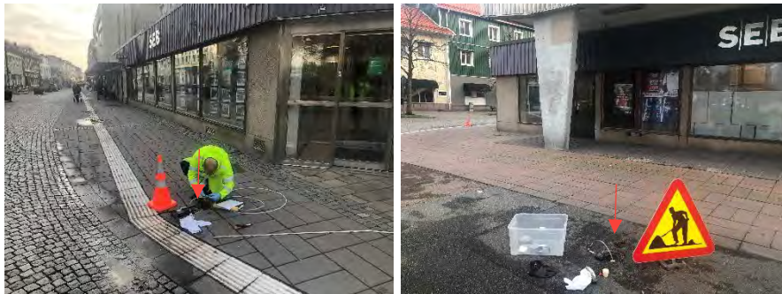
Figur 16. Pumpad gasprovtagning över kolrör med SKC-5000. Kontroll av flödet med rotameter. Provtagningsspjut för provpunkt GAS4 till höger och GAS3 till vänster.
