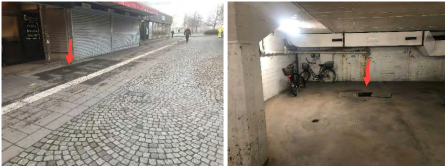
Figur 13. Dräneringsbrunn placerad i trottoaren markerad med röd pil (vänster). Pumpgrop i parkeringsgaraget markerad med röd pil (höger).
