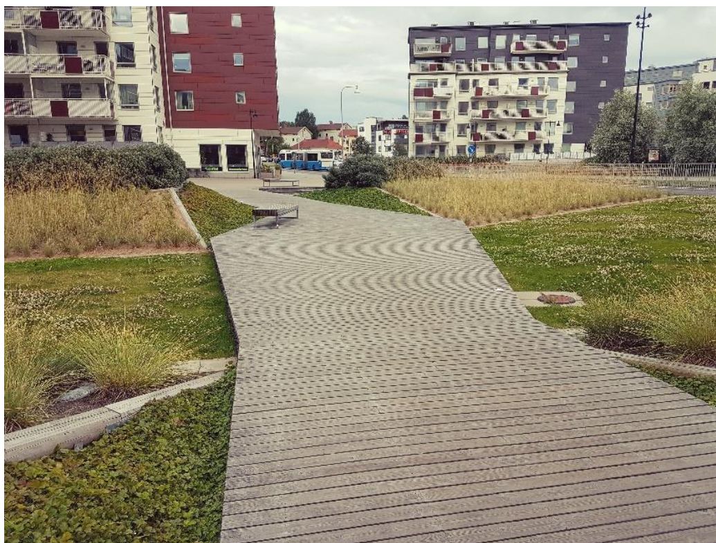
Figur 8: Trägång över yta för dagvattenhantering. Foto: Sweco.
