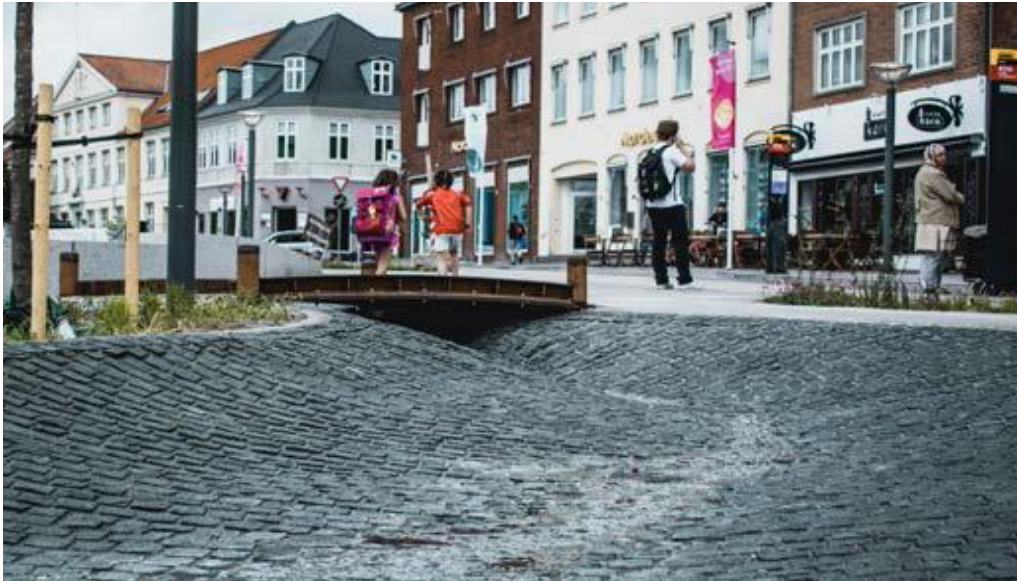
Figur 29. Exempel på större öppen rännan i urban miljö med ungefärlig kapacitet på ca 2300 l/s (Ringsted, Danmark, foto: Ramboll).
