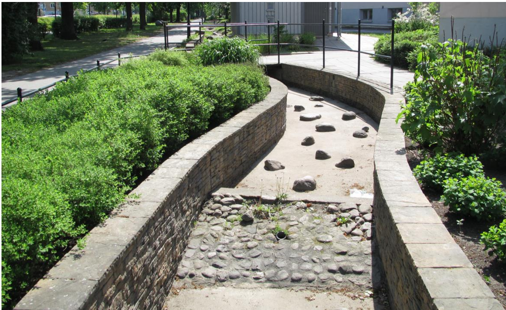
Figur 28. Skyfallsränn med kapacitet på ca 3800 l/s, Augustenborg, Malmö (Foto: Ramboll).
