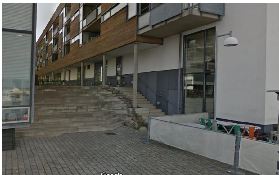
Figur 32. Del av byggnad tillåts översvämmas. Konstruktion samt verksamhet behöver anpassas mot denna förutsättning. (Foto: Google, 2021)
