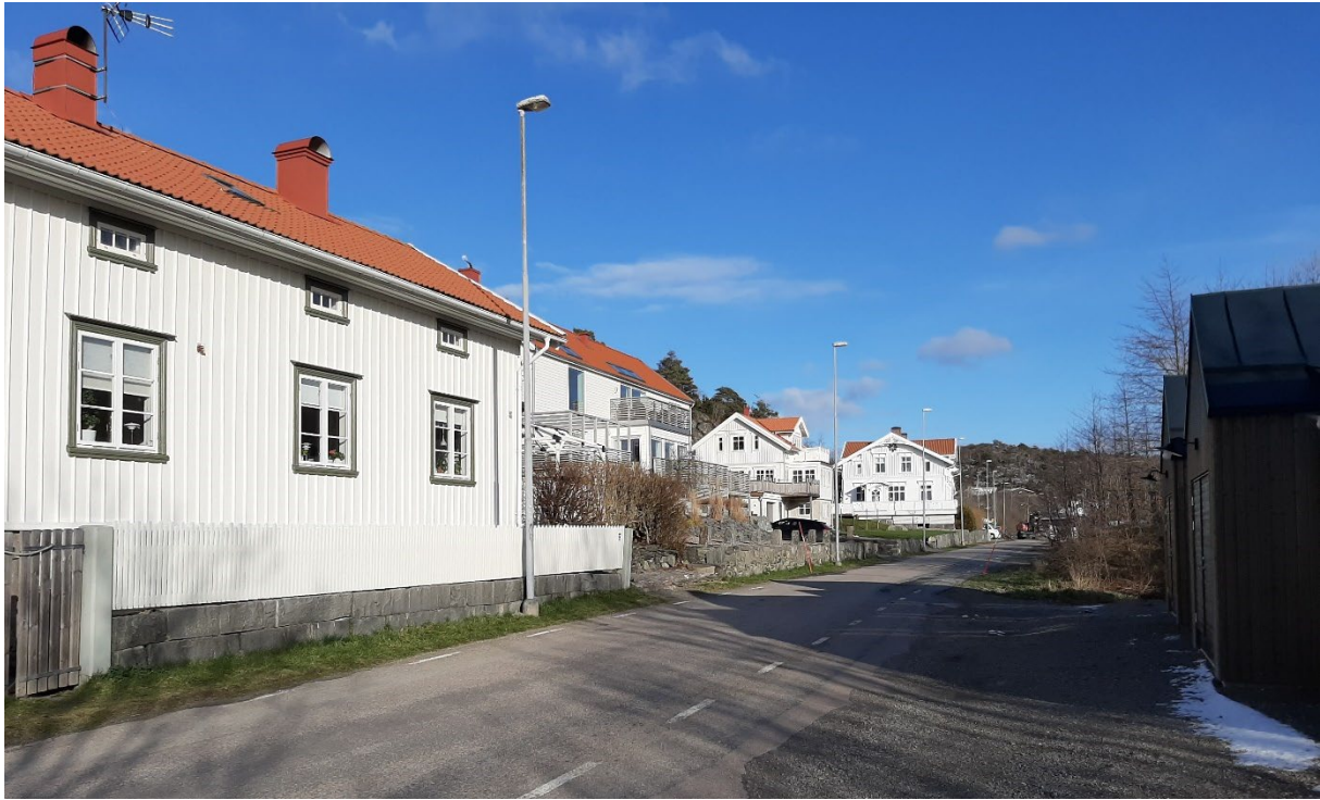
Figur 23. Bebyggelse längs västra delen av väg 612.
