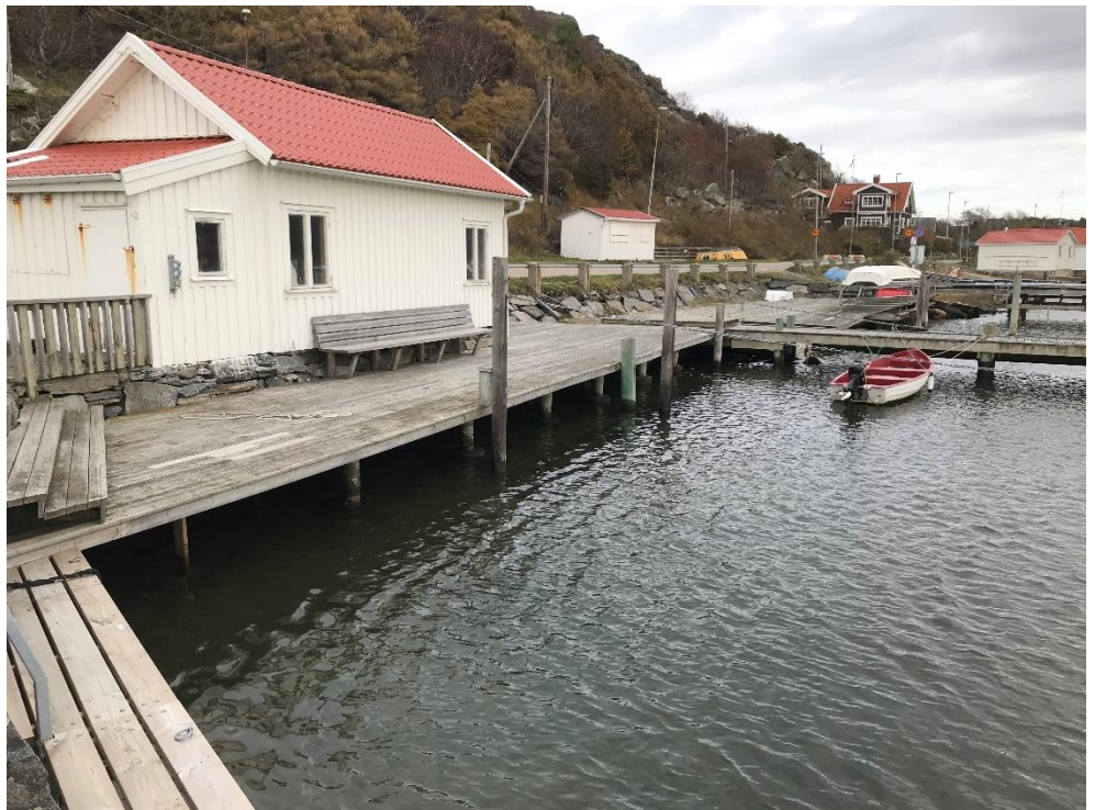
Figur 5. Småbåtshamnen. Berg i dagen skymtas längst bak i bild, fotograferat från sydväst (COWI AB, 2019-10-23)
