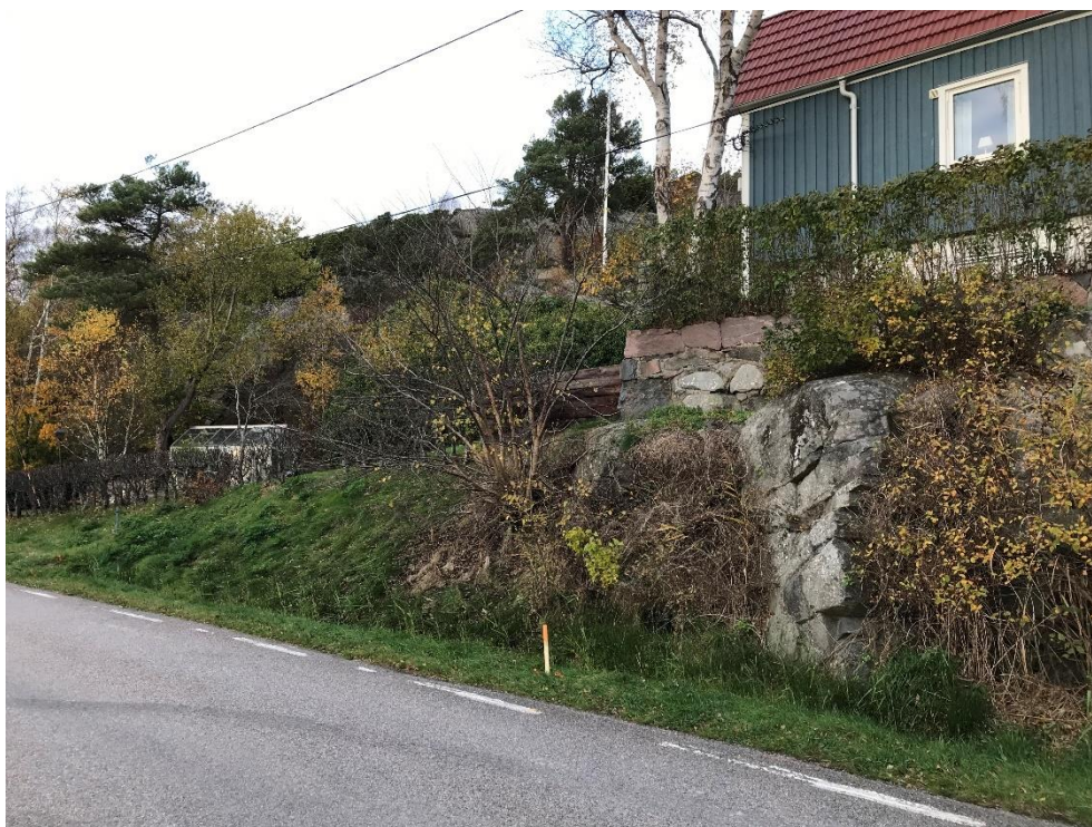
Figur 10. Norr om Väg Tjuvkils Huvud i den östra delen av området. Berg i dagen skymtas i bild. Fotograferat från sydöst (COWI AB, 2019-10-23)
