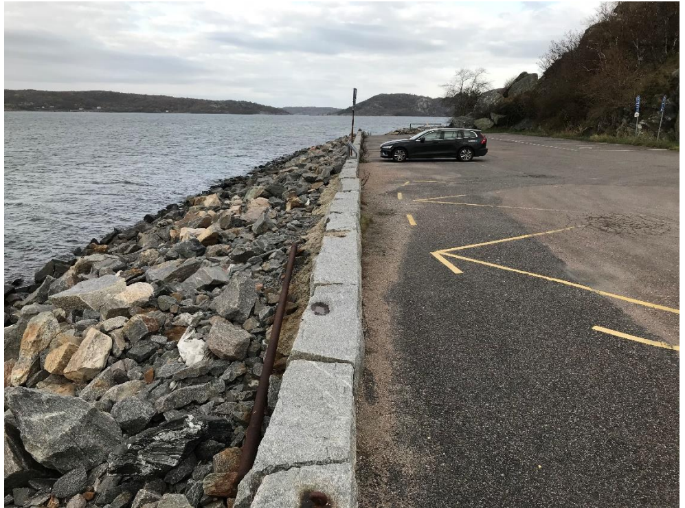
Figur 4. Befintlig parkeringsplats. Erosionsskyddet syns till vänster i bild, fotograferat från sydväst (COWI AB, 2019-10-23)
