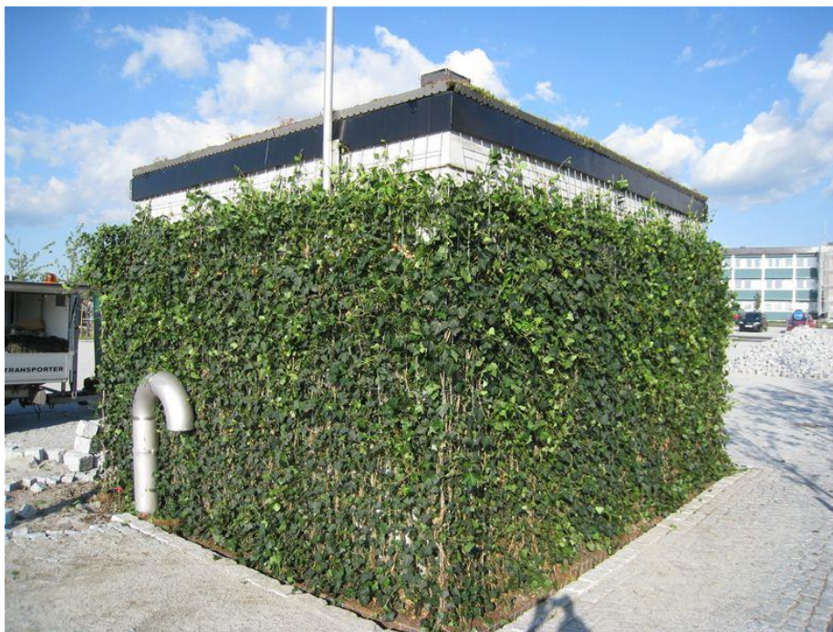
Exempel på utformning av pumphus med grön fasad.
