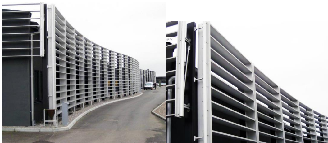
Exempel på omsorgsfull utformning av stängsel som integreras i del av fasad.
