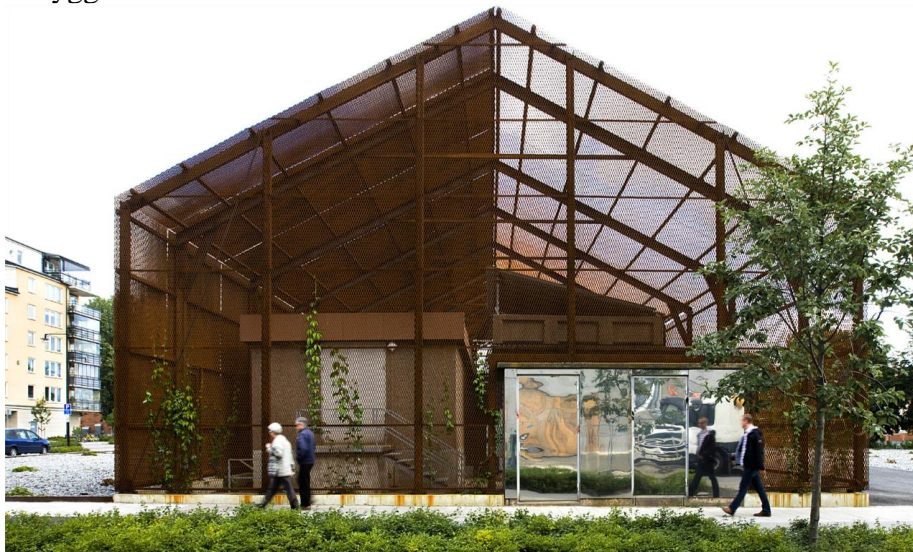
Exempel på omsorgsfullt utformat ställverk i Uppsala. Arkitekt: White.
