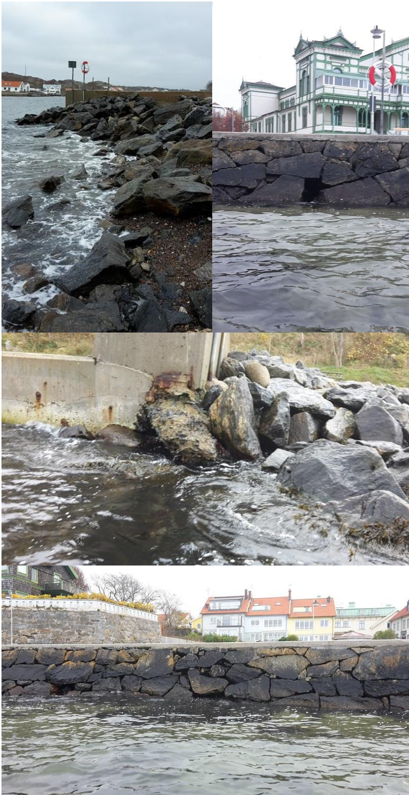
Bild 6. Erosion vid stenkaj.
