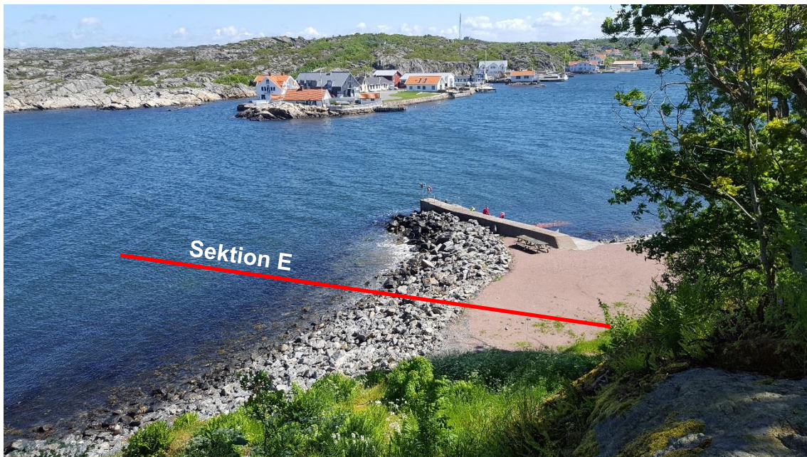
Bild 9. Vändplanen och befintligt erosionsskydd, sektion E.
