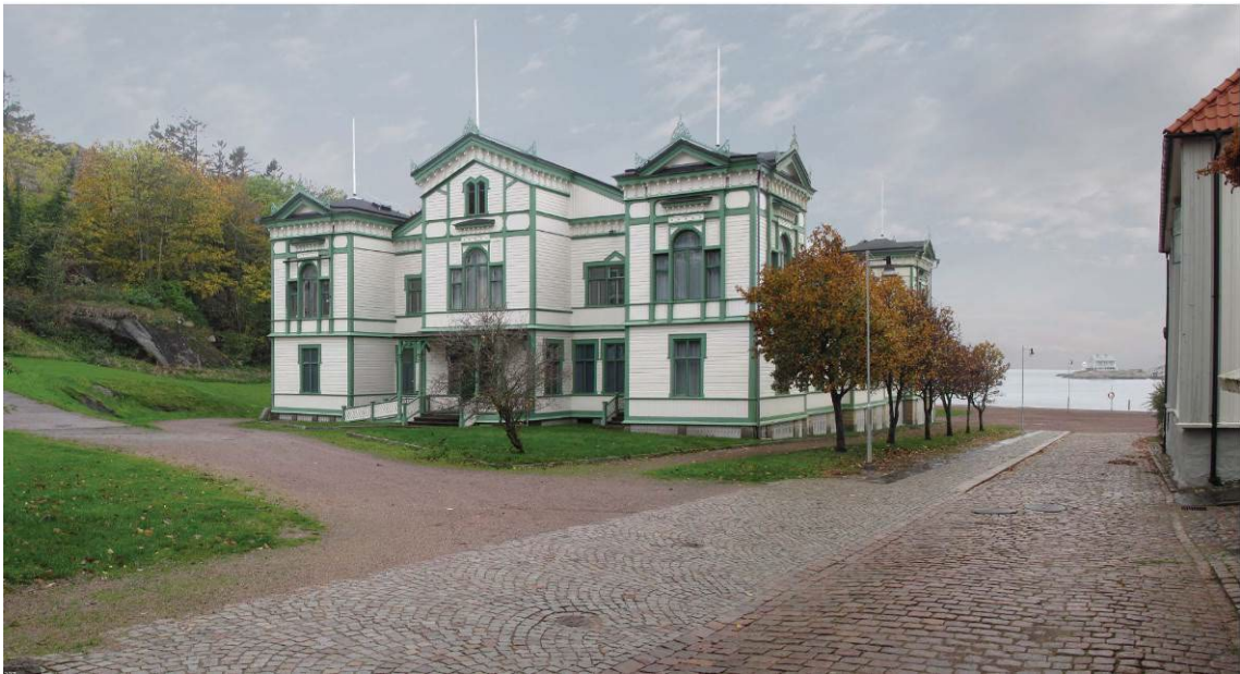
Befintligt utseende, fasad mot söder.
