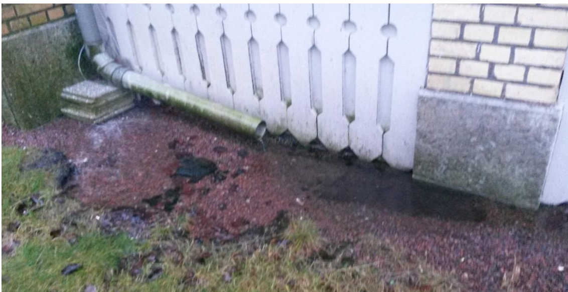
Figur 15. Dagvattenhantering från taket i societetshuset.
