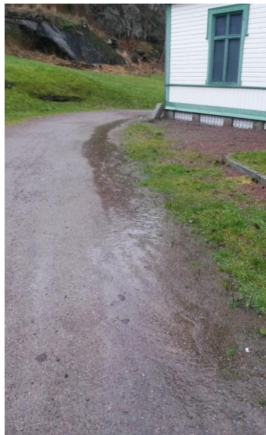
Figur 18. Dagvatten som rinner längst med den högra sidan av vägen.
