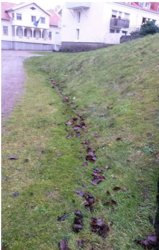
Figur 17. Dike som anlagts i område C.
