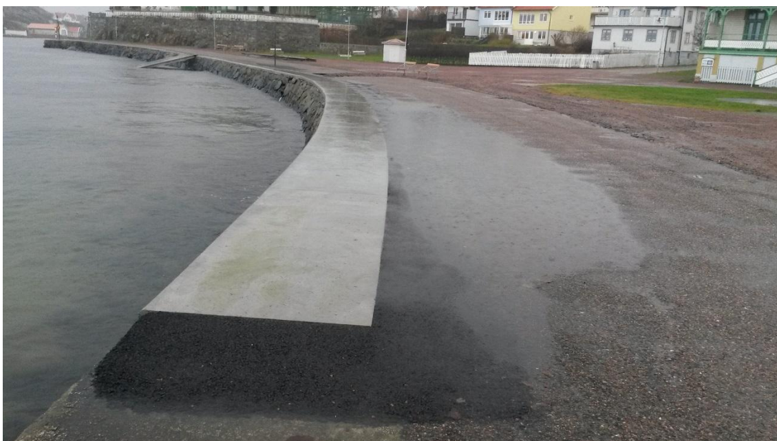
Figur 21. Kajkanten har förstärkts i planområdet.
