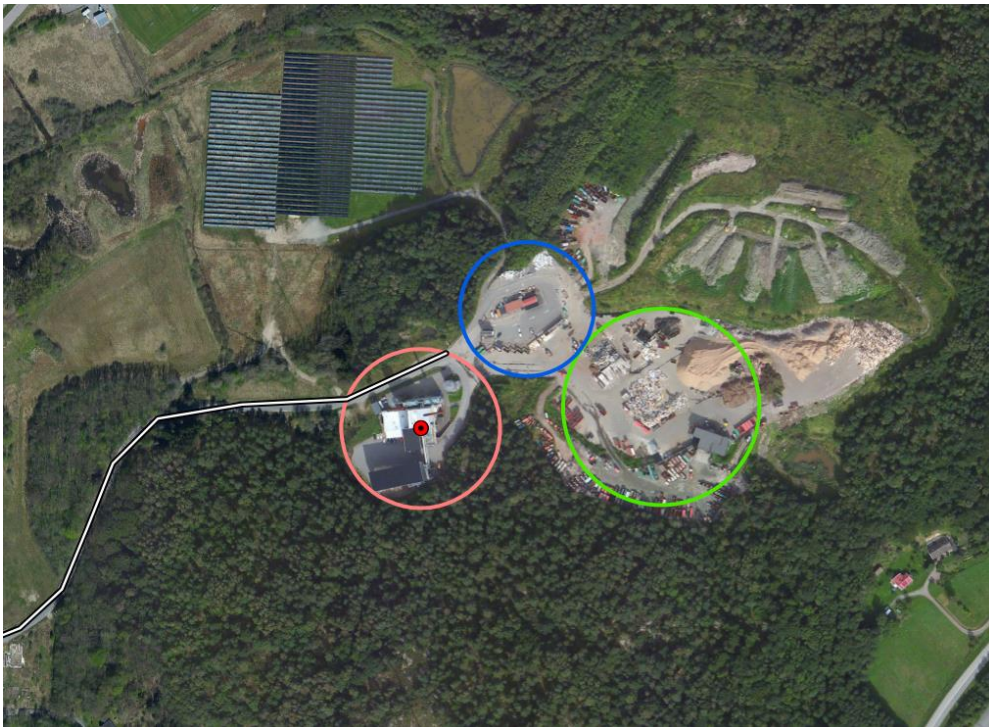
Figur 1. Orienteringsfigur. Röd prick med omgivande rosa cirkel markerar Munkegärdeverket. Blå cirkel markerar Munkegärde ÅVC. Grön cirkel markerar Renova sorteringsanläggning. Vit linje markerar Energivägen. Norr om Munkegärdeverket finns ett solfångarfält. nordöst i bild är en äldre deponi belägen.
