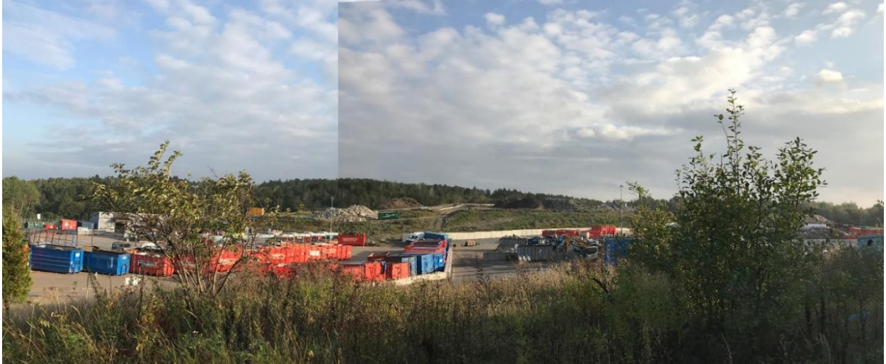
Figur 4. Vy mot nordöst: återvinningscentral, sorteringsanläggning och omlastningsstation, hösten år 2020.
