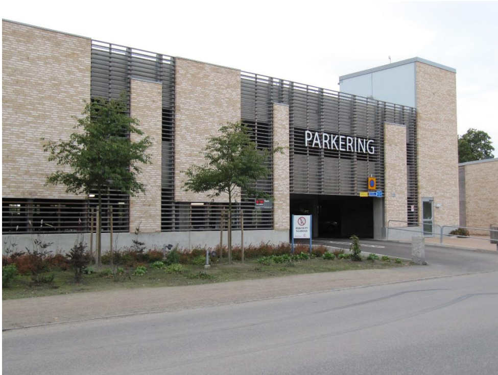
Figur 6-7 Parkeringsanläggning i Ängelholm med enkel stomme och förskönande inslag i fasaden. Foto: Norconsult
