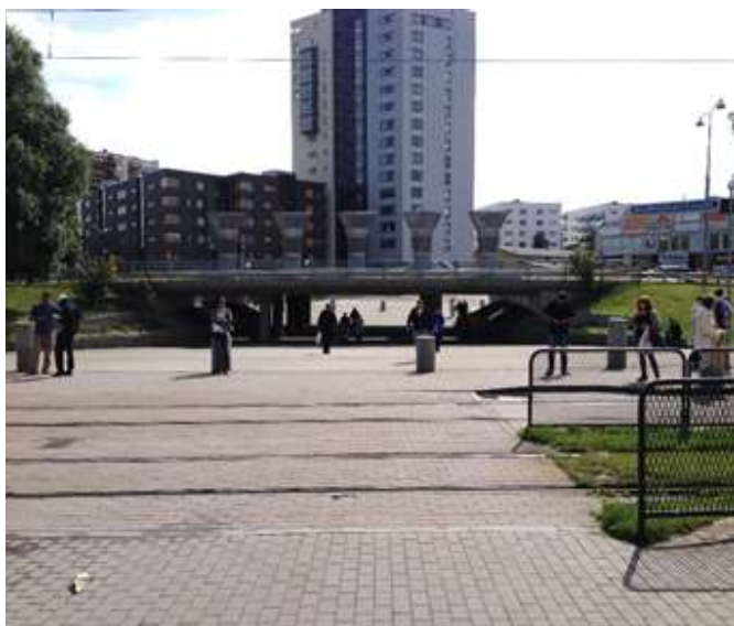
EXEMPEL PÅ BRED, TRYGG GÅNGPASSAGE VID HJALMAR BRANTINGSPLATSEN, GÖTEBORG.
