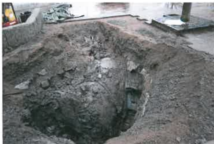
Figur 3. Del av cisternen gick in under trädkronan och trädets rotsystem.
