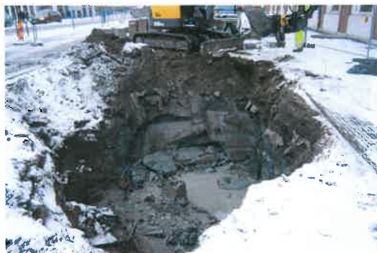
Figur 4. Under cisternen fanns en bottenplatta i betong som senare grävdes upp och transporterades till RagnSells mottagningsanläggning i Heljestorp.
