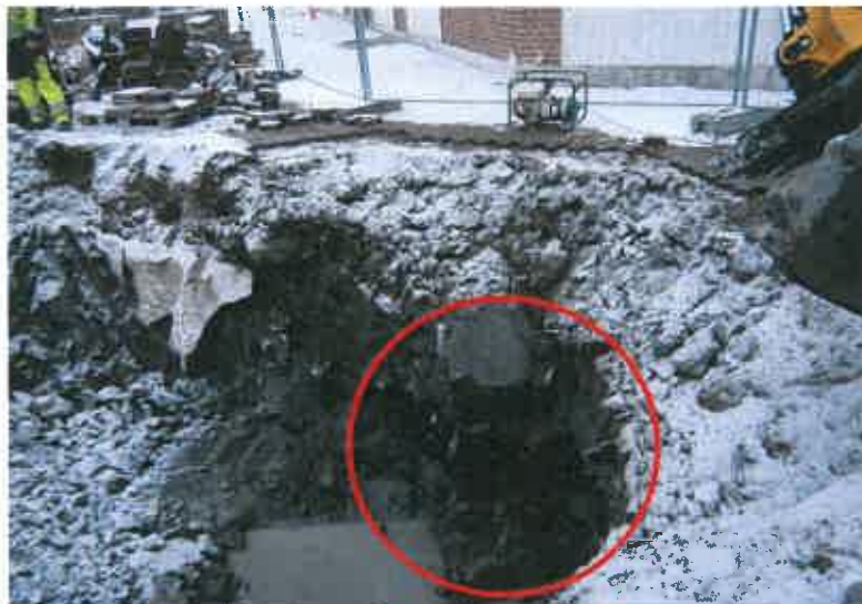
Figur 5. I schaktväggen in mot byggnaden påträffades ytterligare en bottenplatta (inringad med rött).
