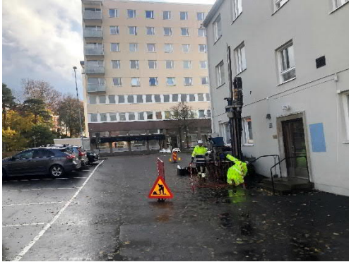
Figur 8. Skruvborring av provtagningspunkt GV1d (djup). Ytlig geologi bestående av stenigt grusigt sandigt fyller 0-2m.
