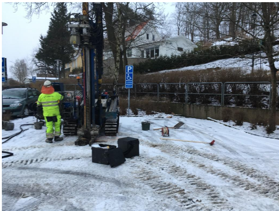
Figur 12. Installation av grundvattenrör GV1d-Röd. 1-tums filterspets av stål 0,5m
