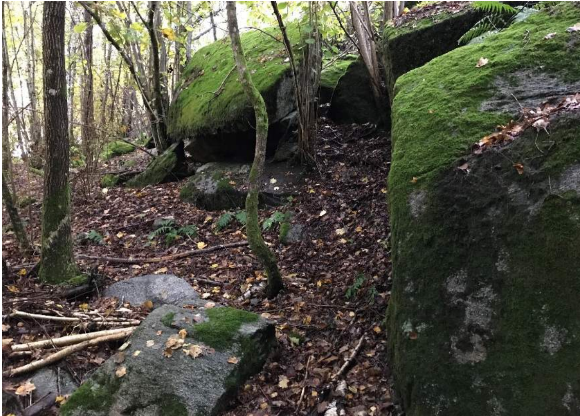
Figur 7. I södra området observerades blockutfall i riktning mot bebyggelsen dock på en jord- och träbäddad terrass.
