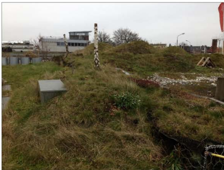
Figur 15. Intensivt grönt tak med kraftigt varierande substratdjup (Foto: Johan Emanuelsson).
