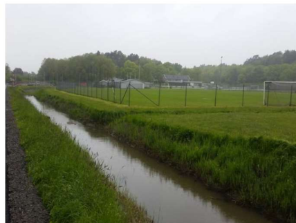
Dike längs Ytternvägen
