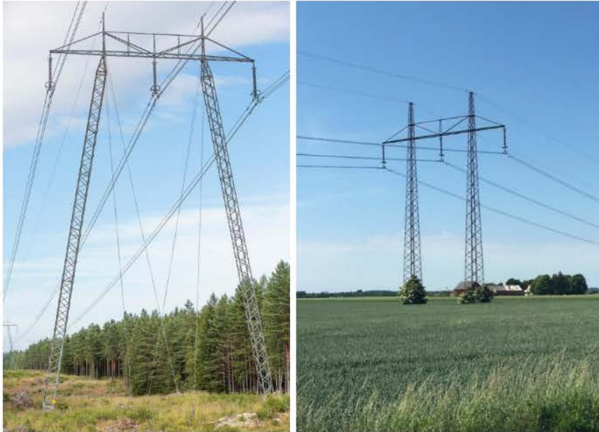
Figur 4. Exempel på stolpar. Stagad A-stolpe (till vänster). Ostagad B-stolpe (till höger).
