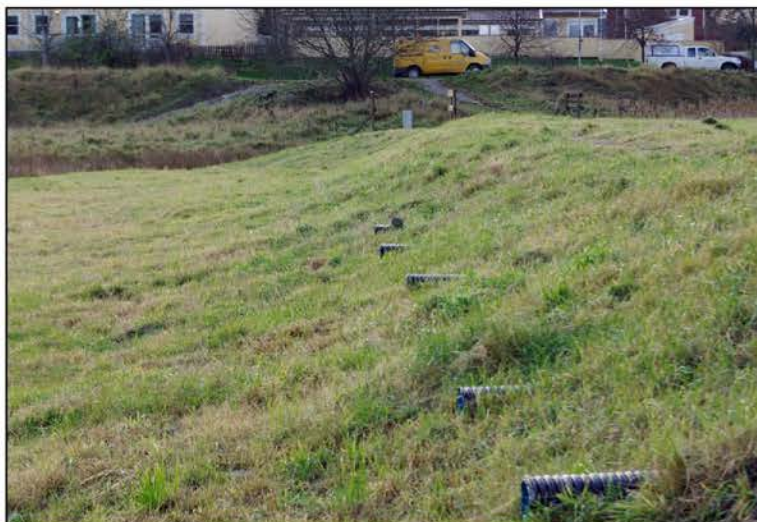
Figur 16. Exempel på torr översilningsyta (Andersson et al., 2013).
