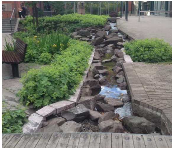
Öppen dagvattenlösning i Oslo
