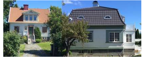
BEVARANDEVÄRDVILLOR I KVARTERET PORTMADEN.
