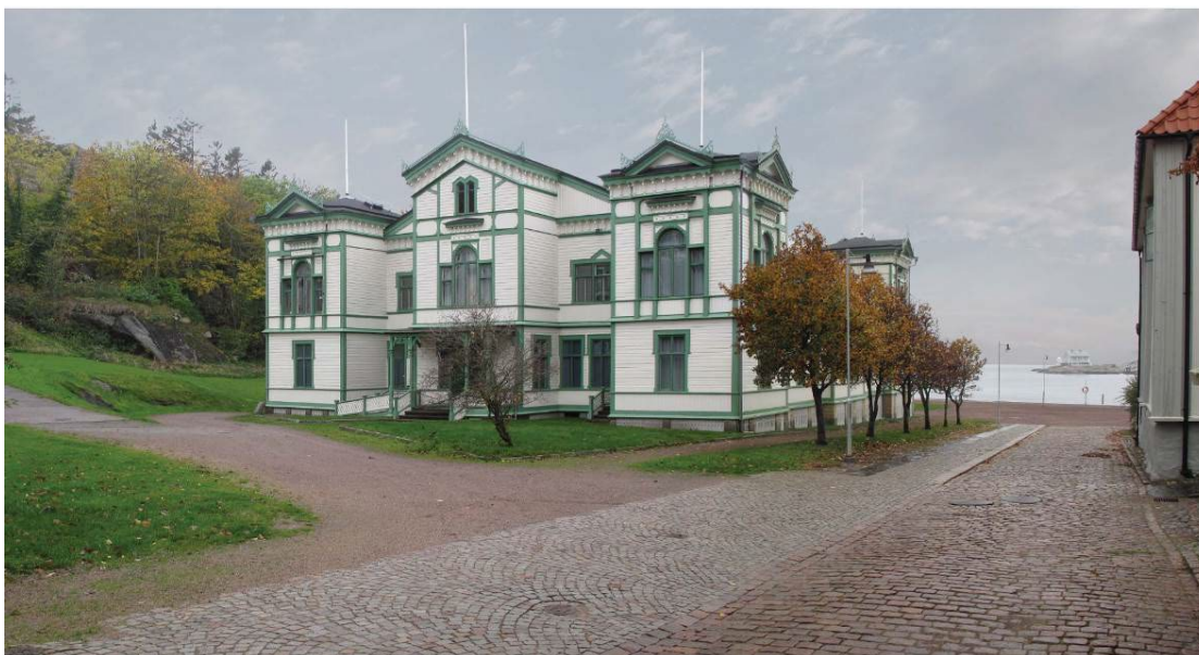
Befintligt utseende, fasad mot söder.
