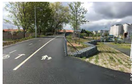
För att göra cykling till ett attraktivt resesätt behöver cykelvägarna till Arenaområdet ha hög kvalitet, likt denna vid resecentret. Generös bredd, jämt underlag och att vägen är gen är grundläggande faktorer. Vackra vyer, trädplanteringar som ger lå och en välkommande entréplats när du når området, gör cykling till ett mer lockande resesätt.
