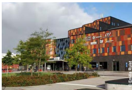
Kviberg Arena i Göteborg har en väl sammanhållen gestaltning där material, formspråk, färgsättning och växtmaterial är genomgående i hela området. Den röda böljande fasaden är karaktärsgivande och bottenvåningen är bitvis uppglasad så att man kan ta del av innehållet i byggnaden.
