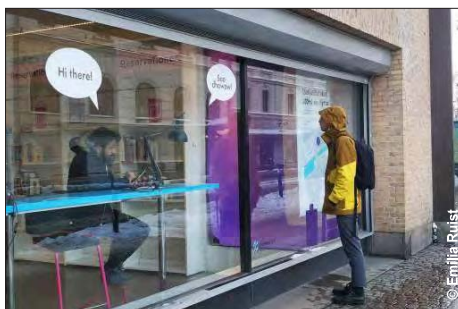
Glasade entrépartier ger möjlighet till kontakt mellan ute och inne. Det bidrar därmed till att området upplevs och blir mer befolkat och tryggt.
