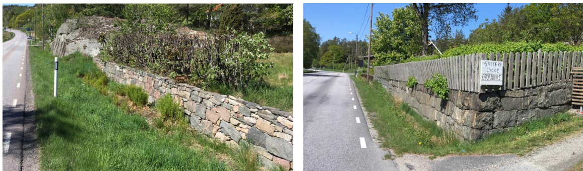
Stenmurar längs vägens norra sida.
