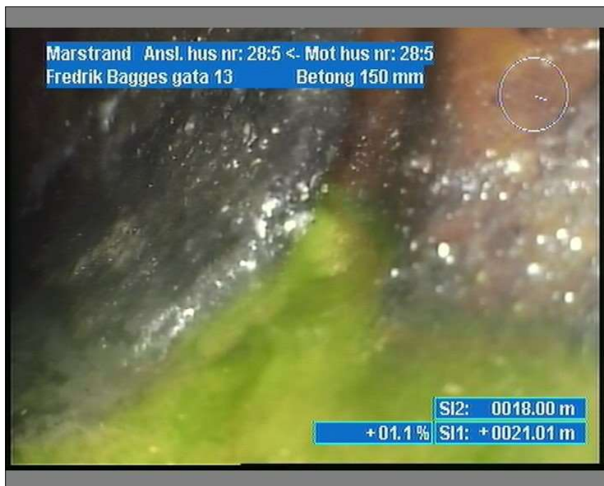
Foto: 6_12A, 00:16:58 18m, Grön färg från S4 via överläckage
