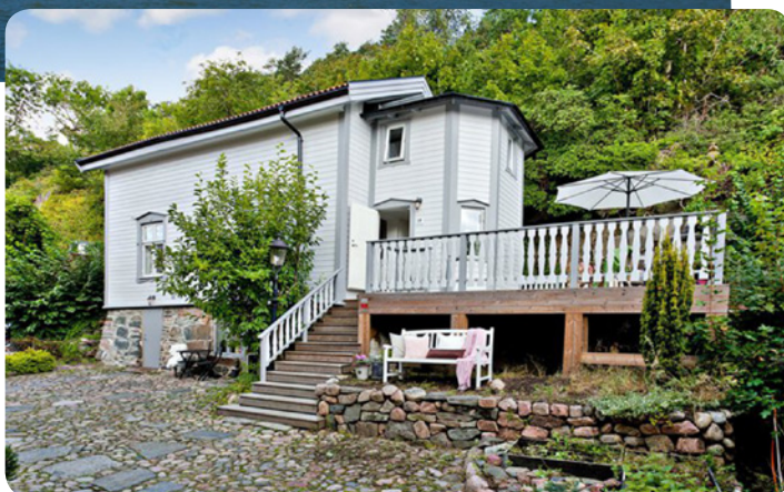
Renoverad äldre enkelstuga med inbyggt trapphus.
