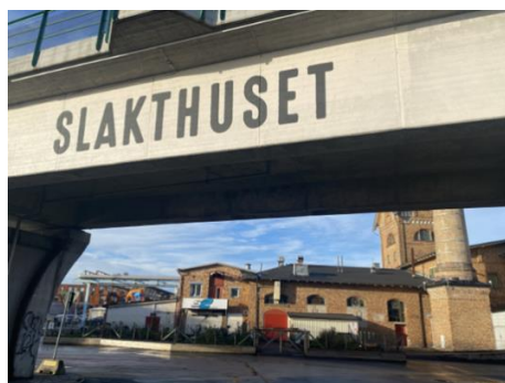
Exempel på bro som fungerar som identitetsskapare och som annonserar en tydlig entré till Slakthusområdet i Göteborg.
