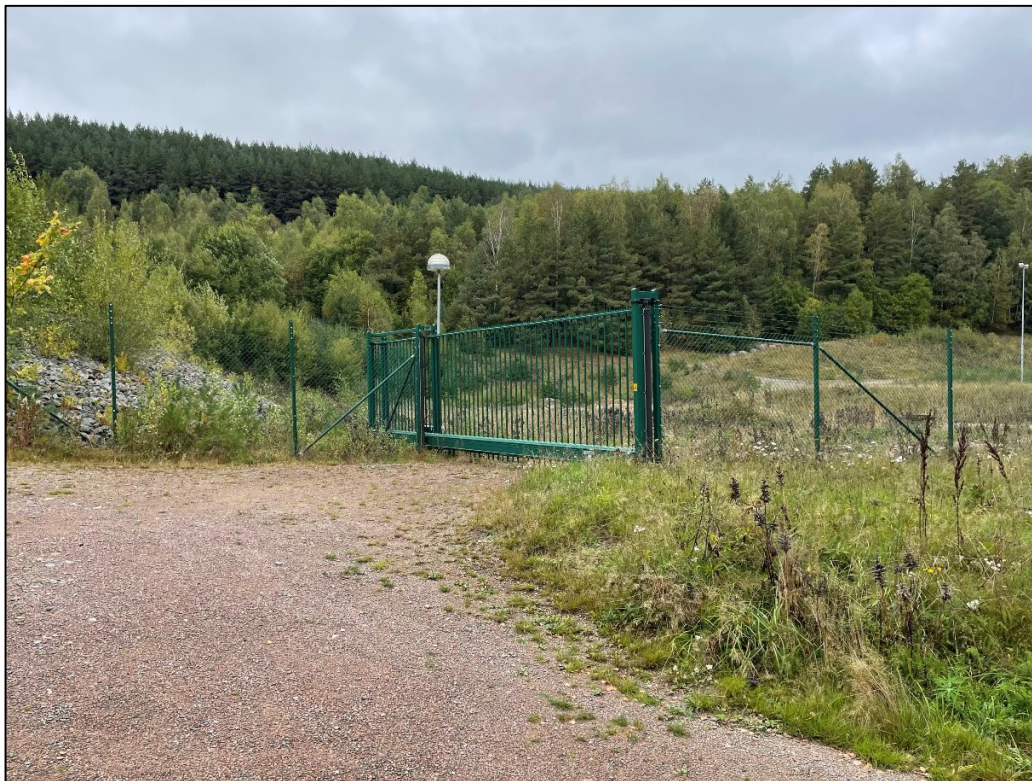
Figur 11. Vattentäktsozonens alla ingående delar ska vara inhägnade.
