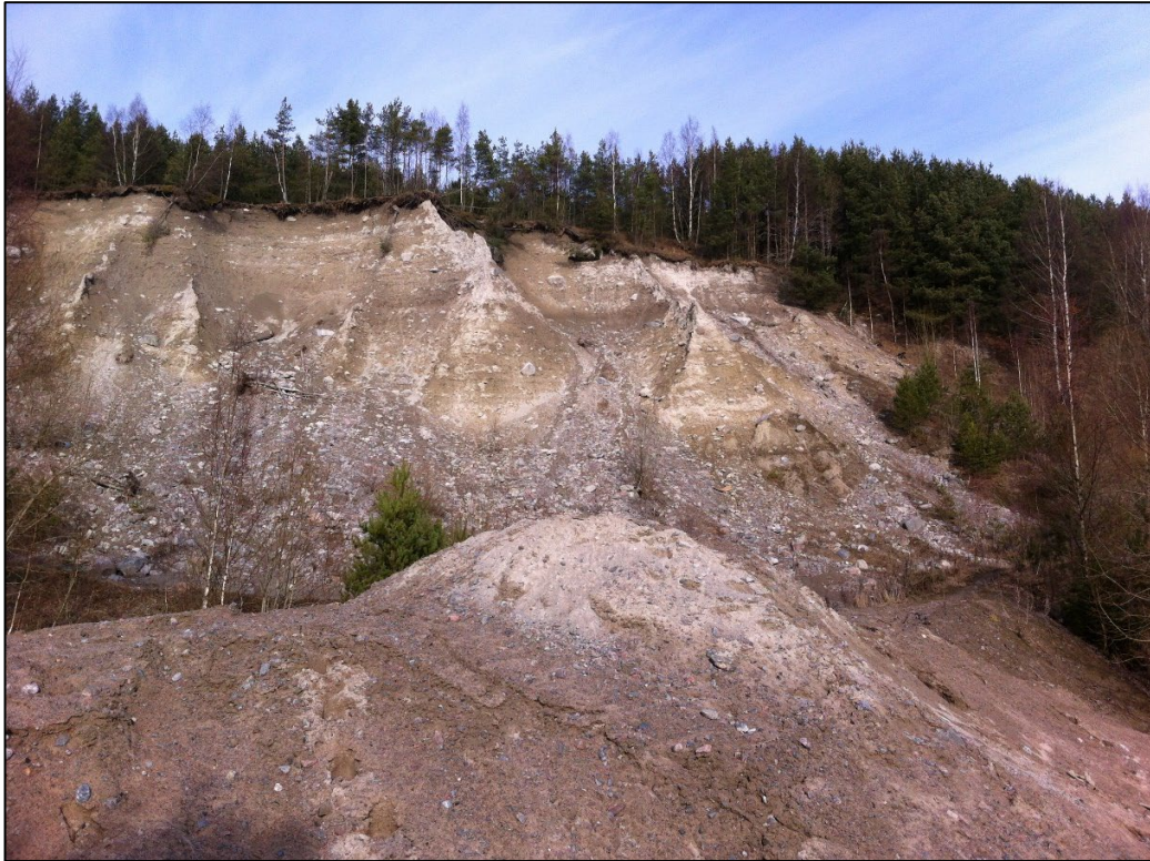
Figur 8. Den avslutade grustäkten och rasbranten mot väster, söder om vattentäkten.
