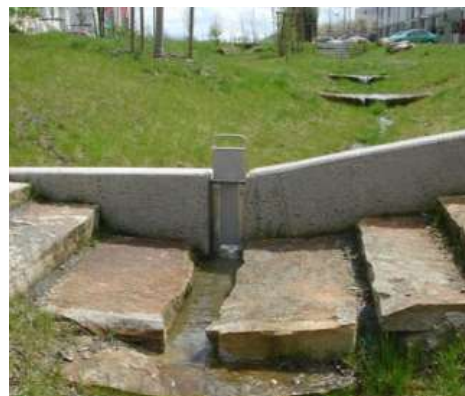
EXEMPEL PÅ DAGVATTENDIKE MED FÖRDRÖJNING. FOTO: NORCONSULT.
