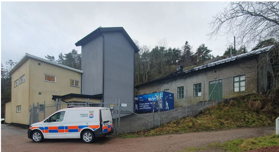
Vattenverket till vänster i bilden och förrådsbyggnaden till höger
