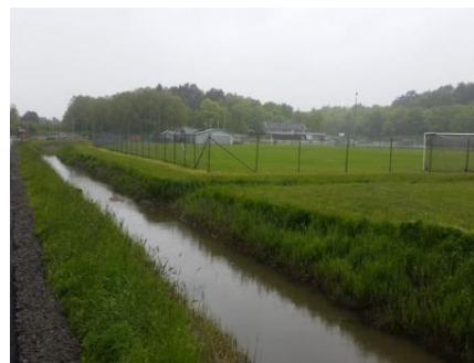
Dike längs Ytternvägen
