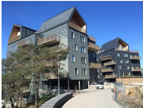
EXEMPEL PÅ BYGGNATION PÅ BERG. FOTO FRÅN NYA HOVÅS, GÖTEBORG.
