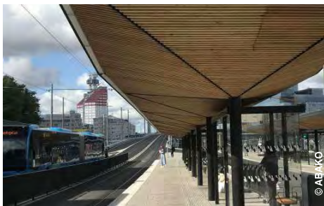
Väderskydd för busshållplats med intresseväckande utformning gör det blir mer lockande att resa kollektivt. Vid hållplatsen Nordstan i Göteborg har ABAKO designat ett veckat tak av träribbor med integrerad belysning.
