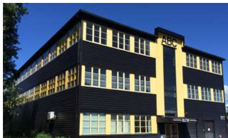
ABC-FABRIKENS GAMLA BYGGNAD ÄR KARAKTÄRISTISK OCH BÖR BEVARAS.
