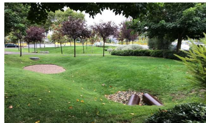
PARKYTA MED MÖJLIGHET ATT OMHÄNDERTA DAGVATTEN, BARCELONA. FOTO NORCONSULT.
