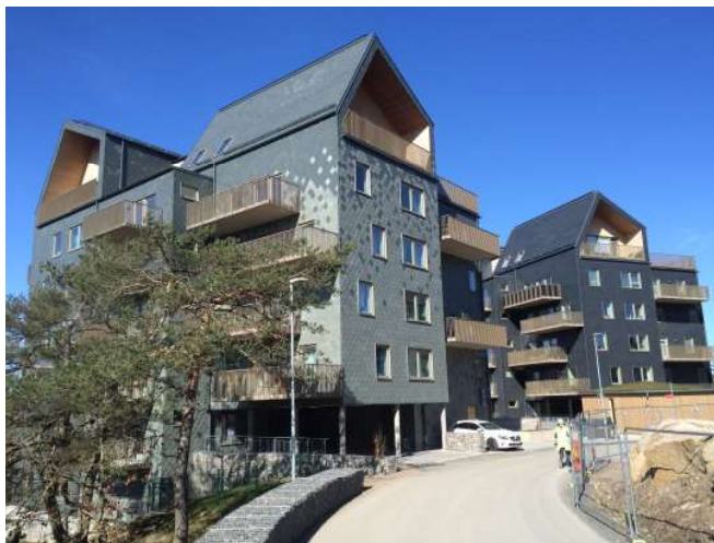
EXEMPEL PÅ BYGGNATION PÅ BERG. FOTO FRÅN NYA HOVÅS, GÖTEBORG.
