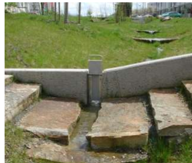
EXEMPEL PÅ DAGVATTENDIKE MED FÖRDRÖJNING. FOTO: NORCONSULT.
