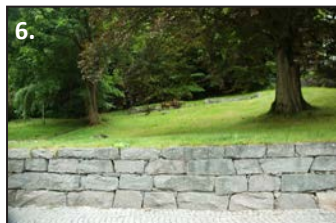
6. Västra gatan Terrasseringsmur mot Fontinberget.
