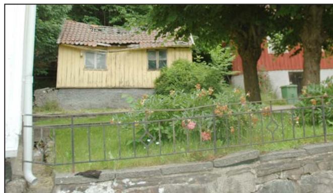
Uthusen är hotade på grund av brist på underhåll eller underhåll med fel material, t ex takläggningmaterial, fönstertyper, panel eller kulör.
