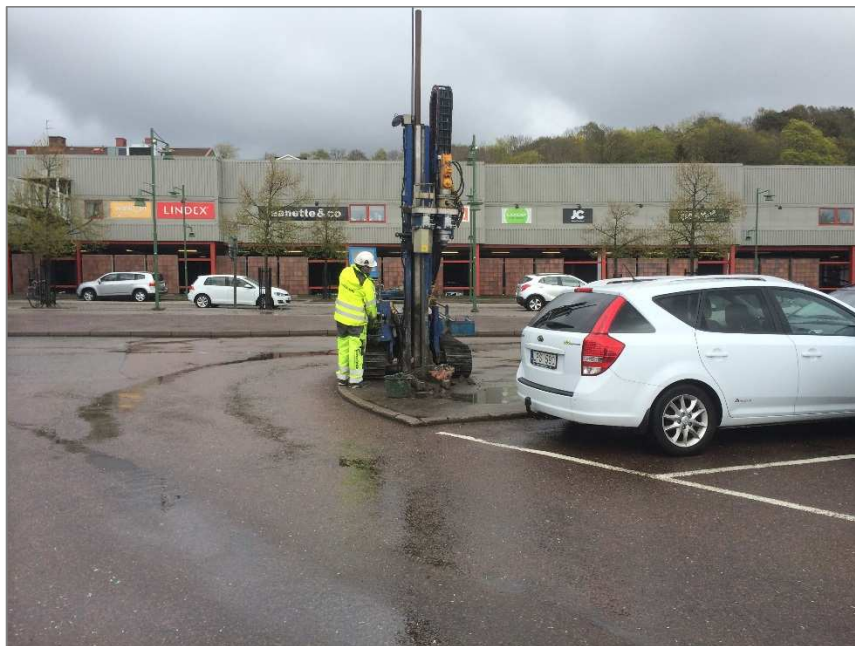
Figur 2. Borrning inom parkeringsytan. Köpcentret med parkeringsgarage, som är beläget inom den östra delen av undersökningsområdet, syns i bakgrunden.
