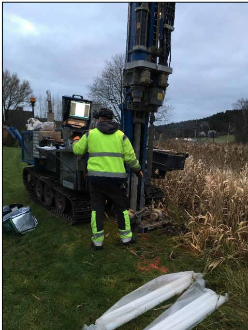
Figur 6. Bild från skruvprovtagningen. Foto: ÅF-Infrastructure AB
