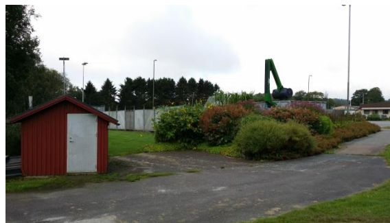
Befintlig pumpstation ”Röda stugan” inom planområdet.
