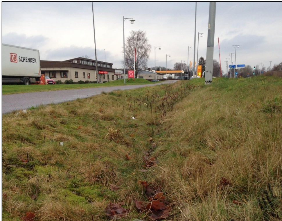
Figur 7. Dike mellan Marstrandsvägen och planområdet, sett från öster (bild från platsbesök).
