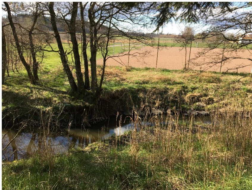
Figur 8. Södra bäcken, erosionsskada syns på båda sidor i bäcken.
