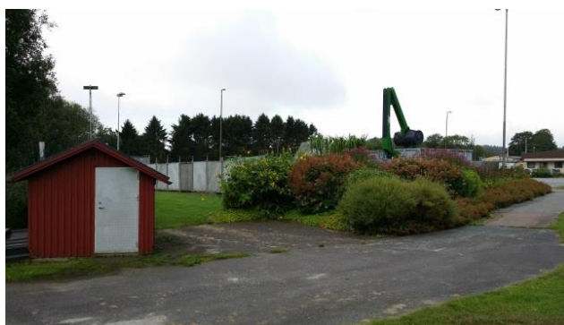
Befintlig pumpstation ”Röda stugan” i nordöstra delen av planområdet.
