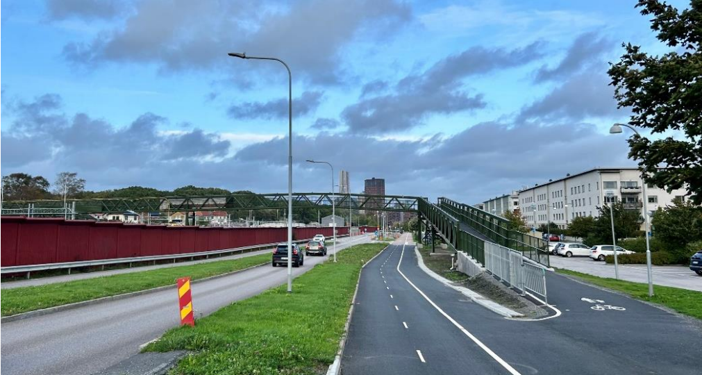
Figur 41. Referens, enkel gång- och cykelbro Göteborg. Rampen är ca 70 meter lång
