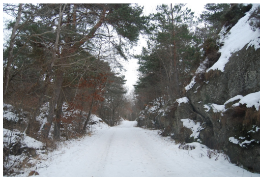
Upp mot området läggs ledningen i vägen, vilket kan innebära problem med berg.
