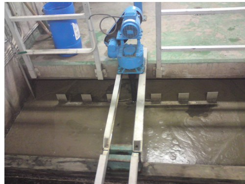
Flockningskammare
