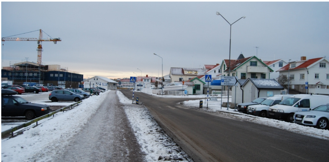
Hedvigsholmen. Anslutningspunkt föreslås ligga i eller bortom korsningen. Parkeringsplatsens avloppspumpstation syns till höger i bilden.
