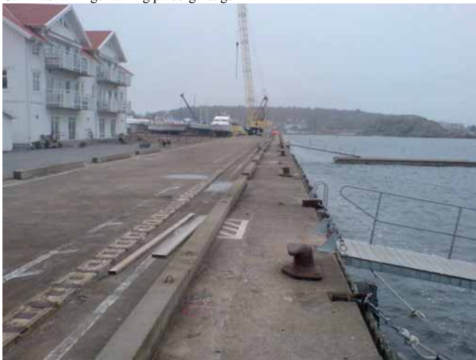
Bild 3. Den pålade kajen, vy åt öster.
