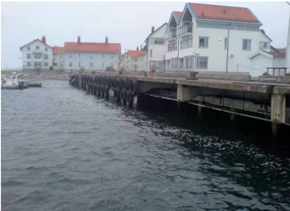
Bild 2. Den pålade kajen, vy åt väster.
