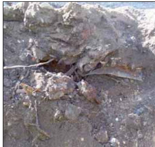
Figur 8 Järnskröt i fyllning vid PG8
