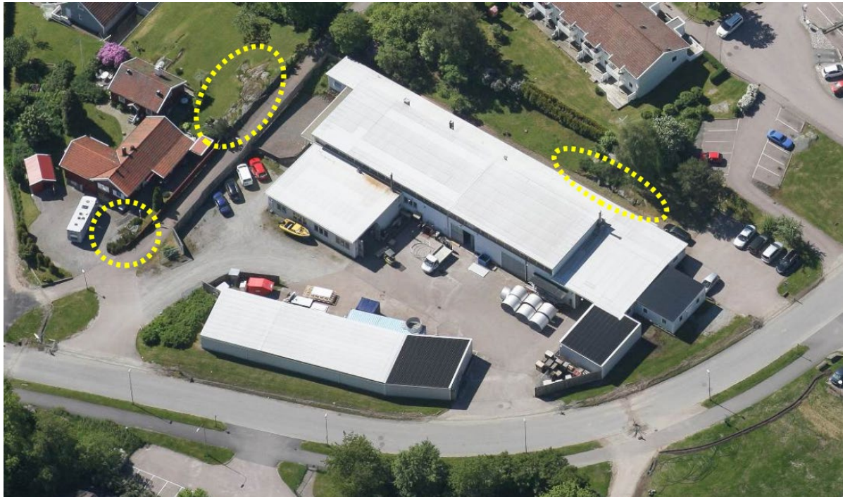
Bild 26. Inom och strax utanför planområdet syns berg i dagen (inringat i gult). Sprängning av berg har skett inför att den större byggnaden uppfördes.
