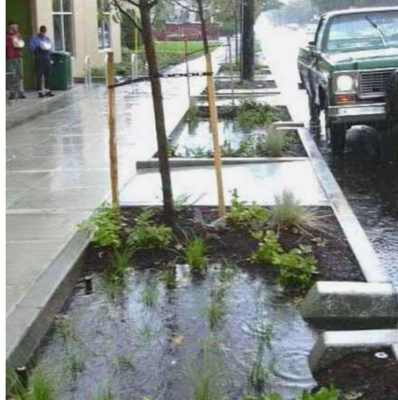
Figur 27. Bilderna visar exempel på nedsänkta växtbäddar med olika typer av inlopp.
