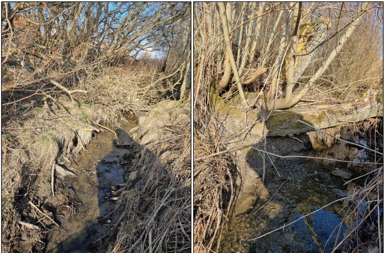
Figur 10-24 – Noterade erosions-skador längs bäcken söder om Hedsvägen, Delområde 5 & 6.
