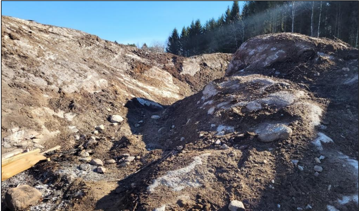
Figur 10-43 – Bergförekomst i södra delen av Delområdet 6. Spägning av berg och schaktarbete pågick i området under platsbesökets tillfälle.
