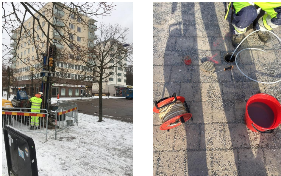
Figur 11. Installation av grundvattenrör GV2d-grön. Renspumpning av grundvattenrör med Wattera-pump
