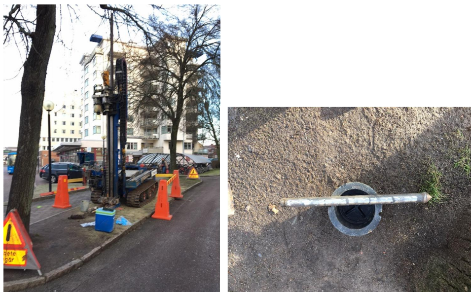
Figur 11. Installation av grundvattenrör GV1d-Röd. 1-tums filterspets av stål 0,5m
