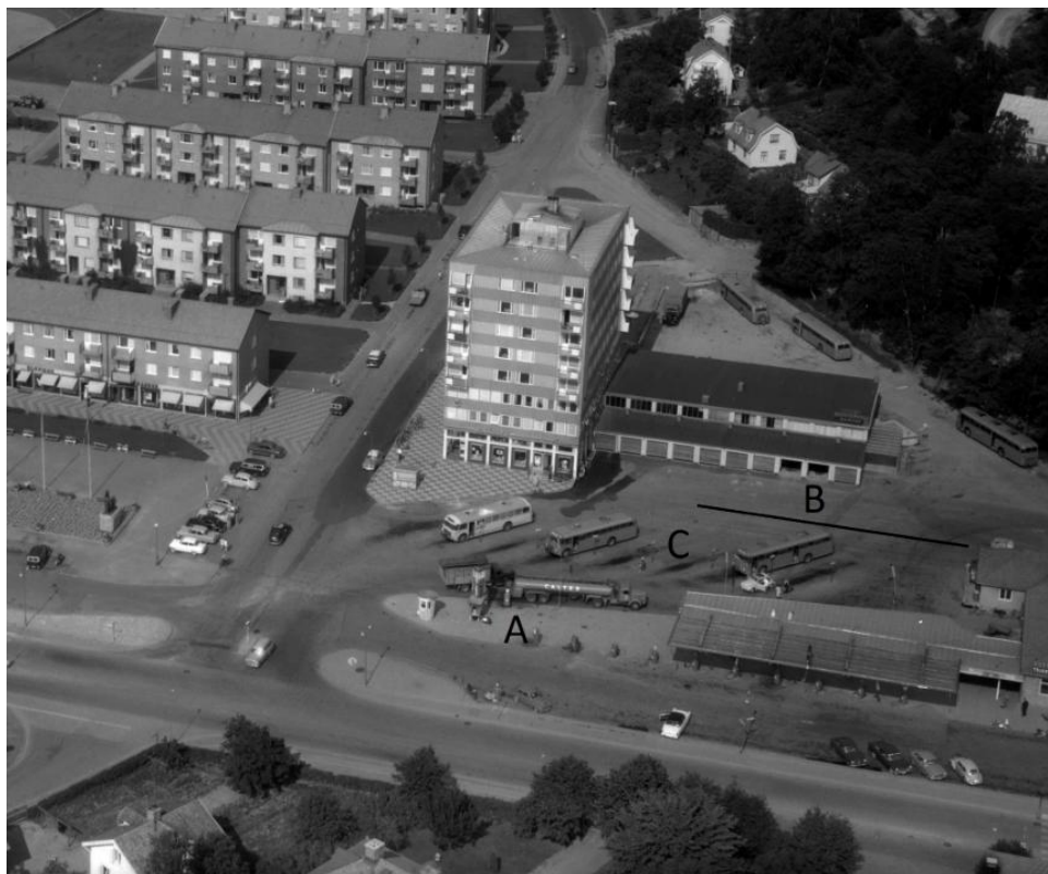
Figur 7. Flygfoto från 1960 över busstationen. A= Ett antal tankar var tidigare nedgrävda där tankbilen står, tankarna var under trottoaren. B= Två streck syns i bakkant på bussen, detta är järnvägsspår fram till den tidigare tågstationen. C= De svarta fläckarna där bussarna står är olja + diesel läckage från bussarna.
