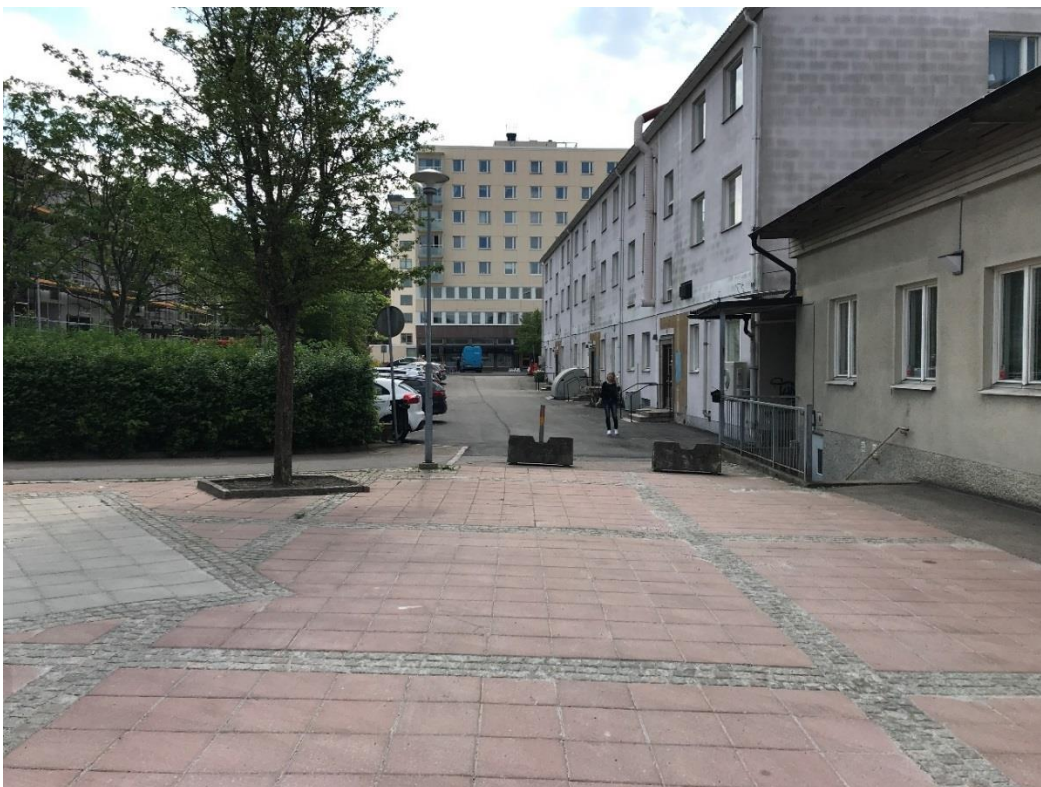
Figur 7. Exempel på byggnad som ligger lägre än omgivande mark.
