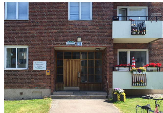
Port och balkong på ett av de fem lamellhusen.
