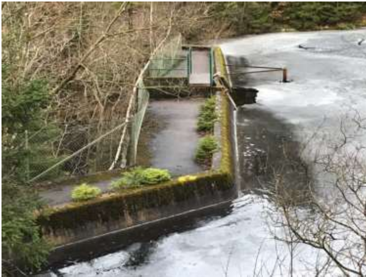
Översikt anläggningar vid Drypesjön.
