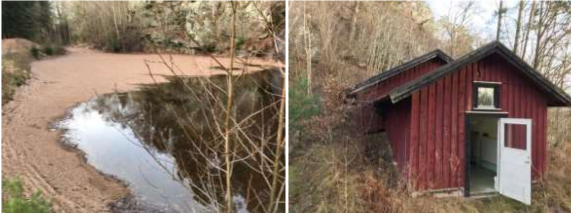
Del av infiltrationsdamm samt mindre byggnad med flödesmätare med mera.
