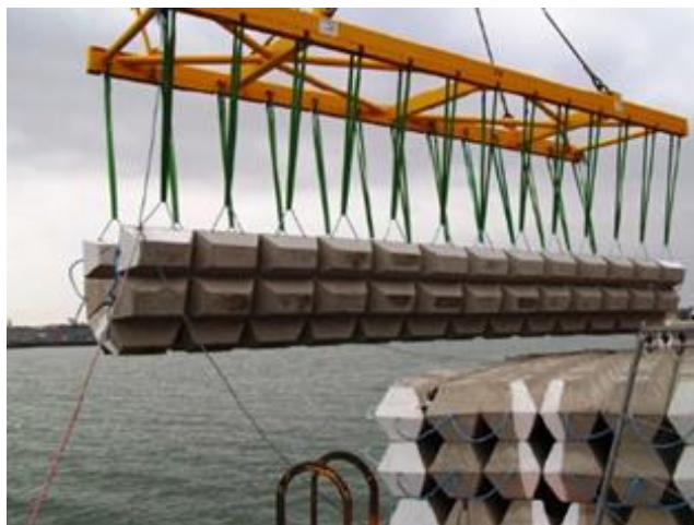
Figur 8. Exempel på övertäckningsskydd i betong.
